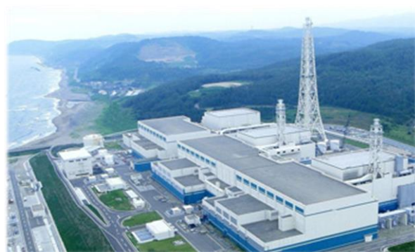
柏崎刈羽原子力発電所
